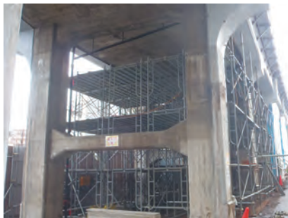
耐震補強工事中の高架橋
