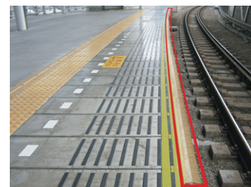
ホーム側面に取付けた転落防止ゴム
