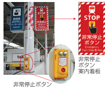
非常停止ボタン
