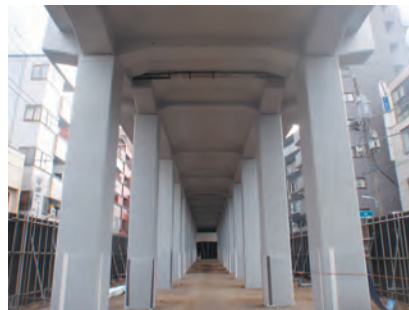
耐震補強工事済の高架橋
