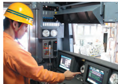
モニターによる車両の保守
