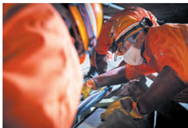
ホーム下(トラフ細部)
