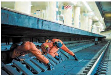
ホーム下(トラフ全体)
