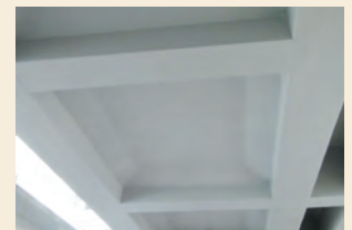
高架橋長寿命化対策後
