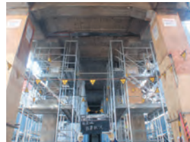
耐震補強工事中の高架橋
