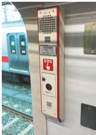
車内非常通報ボタン
