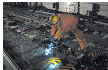
信号設備検査
